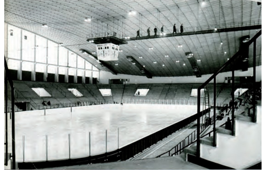
Hallin päätila lopputarkastuksen aikaan vuonna 1965. Tarkastajat kulkevat kellokallilla 18 metrin korkeudessa. Kuva: Hirvikallio, 2015; Leinonen, 2015
